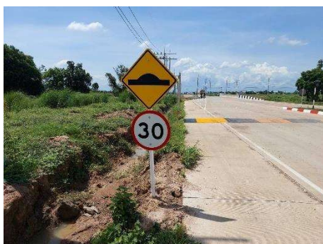
รูปที่ 2-3 ร่องระบายน้ำฝนชั่วคราวในพื้นที่โครงการ
