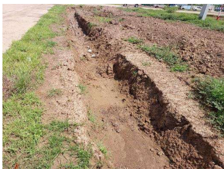
รูปที่ 2-3 ร่องระบายน้ำฝนชั่วคราวในพื้นที่โครงการ
